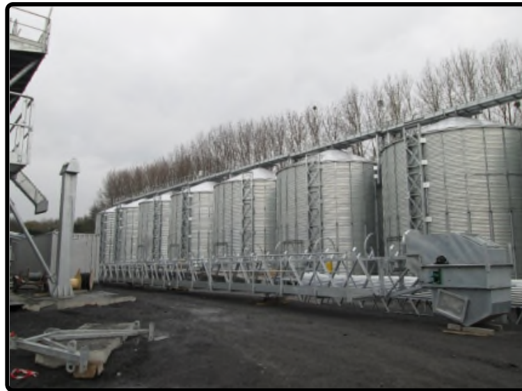
Vue des 11 silos en cours d'installation en juin 2016
